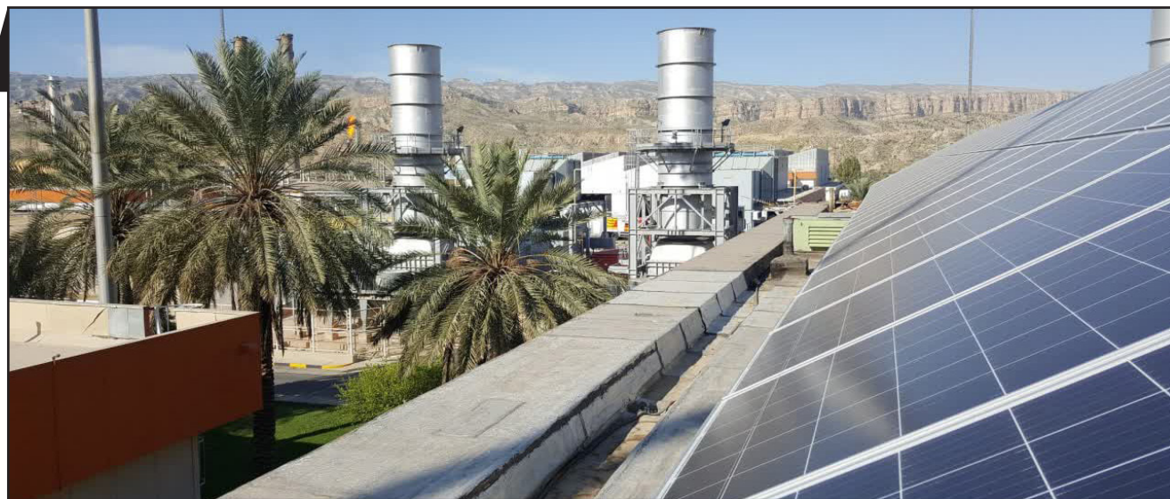
احداث نیروگاه خورشیدی
