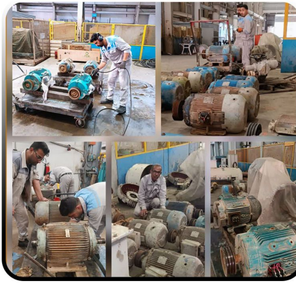
تلاش شبانه‌روزی کارگاه برق؛ آماده‌سازی الکتروموتورهای واحد ۴۴۰۰ در گرمای سوزان
